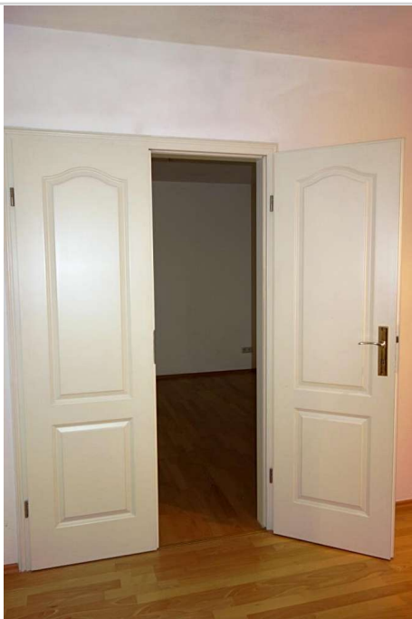
Durchgang zum Wohnbereich
