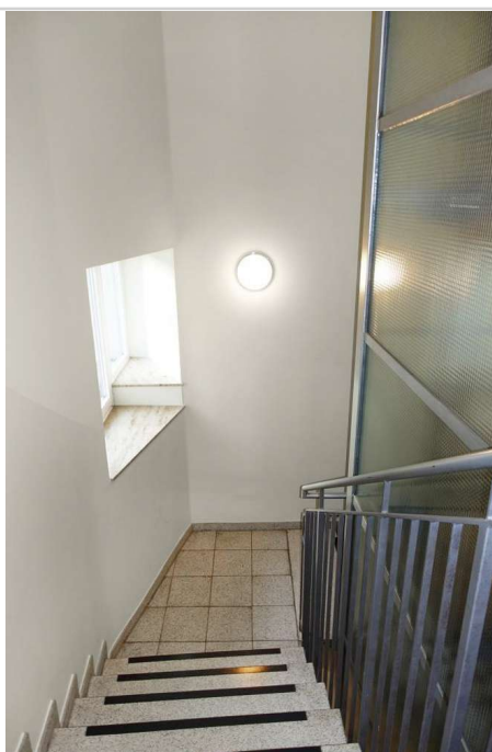
Treppe ins Dachgeschoss
