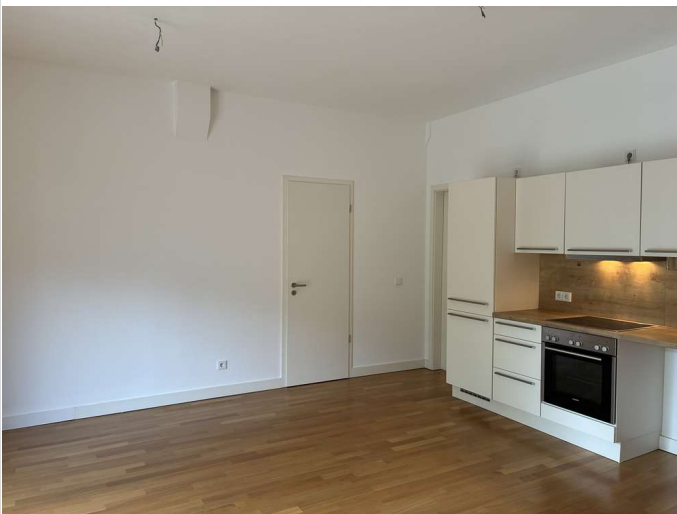
Blick zum Abstellraum
